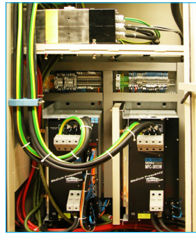
4x transformadores 170 kVA MF y 2 inversers MFC-3015w
